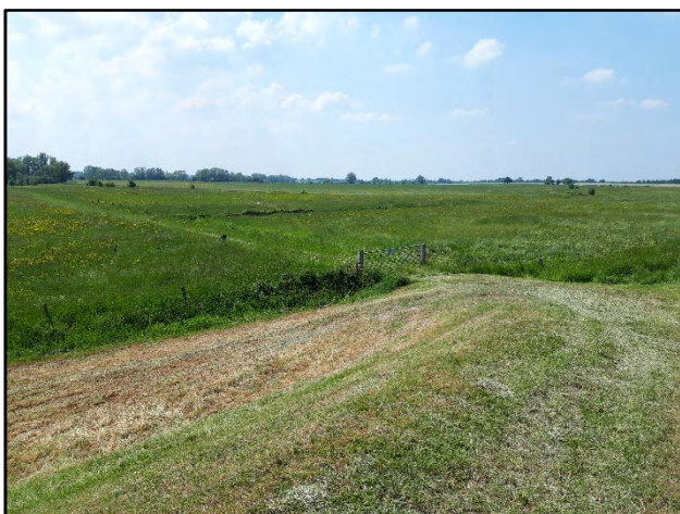
Foto 17: Dam DA08 en pad PA4
