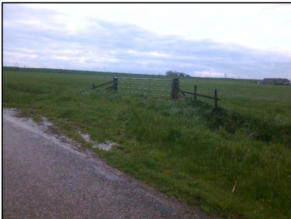
Foto 9: Ligging dam DA5
