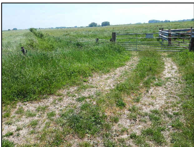
Foto 11: Dam DA05 en pad PA2
