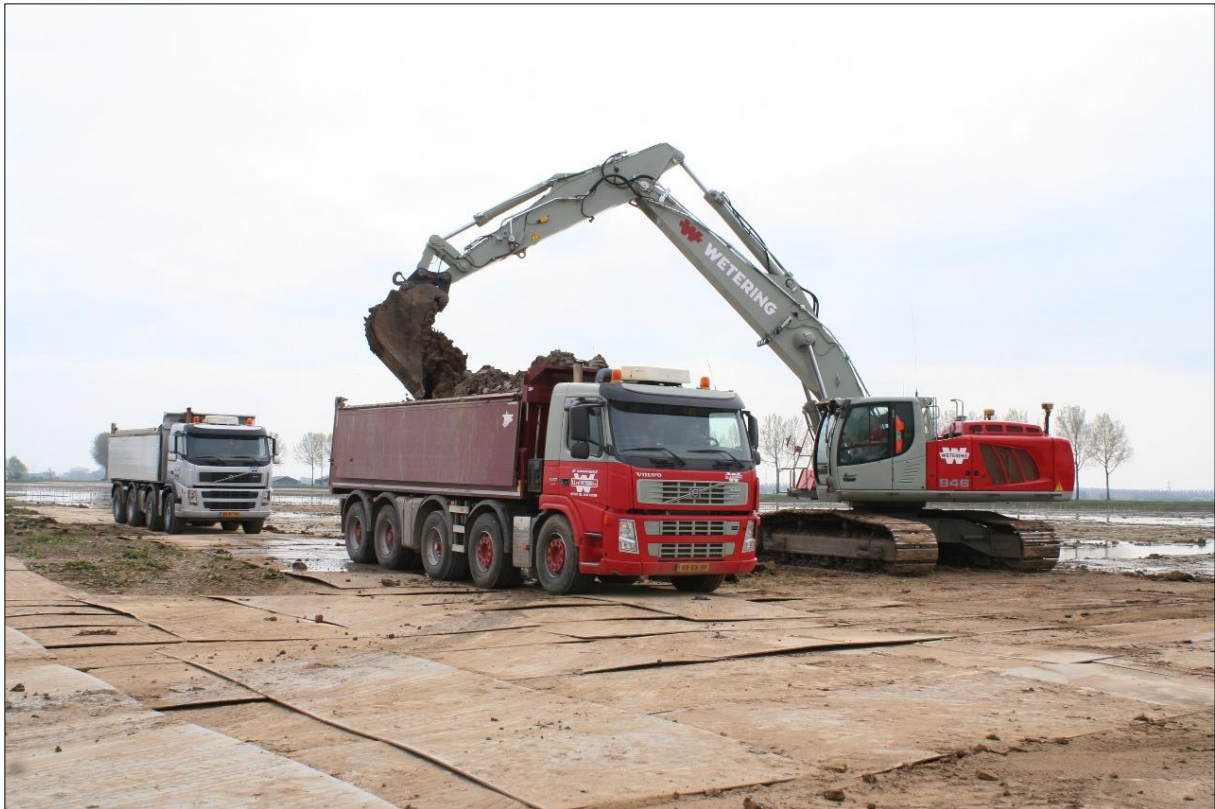
Figuur 6. Afhankelijk van de bodemgesteldheid, het weer en het seizoen zijn mogelijk rijplatenbanen nodig.
