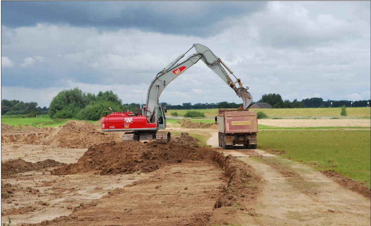
Figuur 4. De klei wordt afgegraven met een (gps-gestuurde) hydraulische graafmachine en vervolgens per vrachtwagen getransporteerd naar de oever van de Lek.
