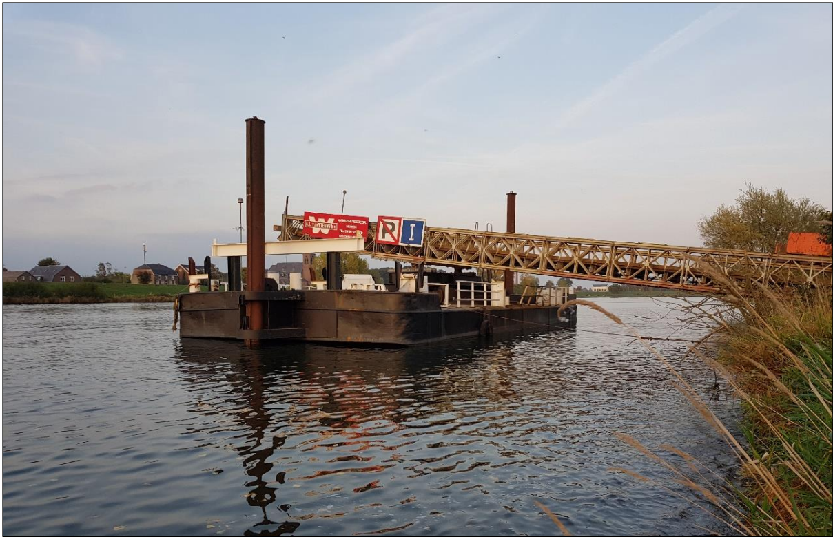
Figuur 7. De mobiele laadbrug rust op een drijvend ponton, welke met spudpalen is verankerd.
