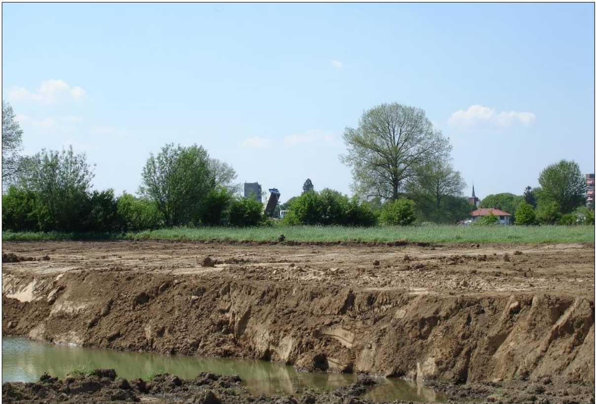
Figuur 5. Op de voorgrond is klei ontgraven, op de achtergrond enkel de bovengrond.
